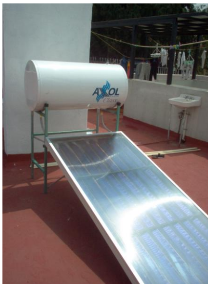
Foto N° 3.- Colocación de los paneles solares y del calentador en el área asignada.
