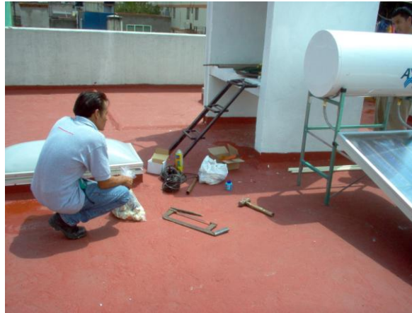
Foto N° 4.- Proceso de instalación.
