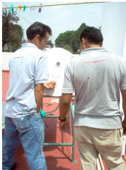
Foto N° 5.- Colocación de las válvulas de paso en el calentador solar.
