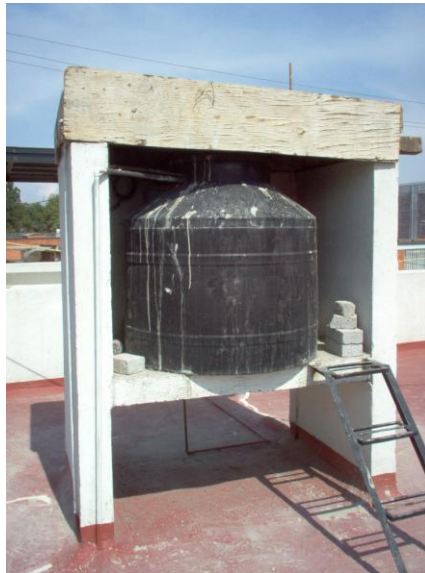
Foto N° 1.- Tinaco de la oficina del Cinam en su posición inicial antes de la instalación, 0.80 m de la azotea a la base del tinaco.
