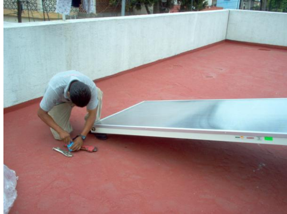
Foto N° 6.- Fijación de los paneles solares a la losa de la azotea.
