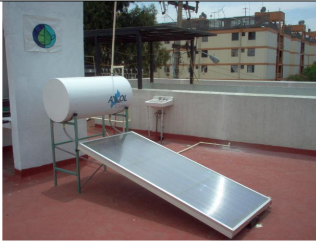
Foto N° 10.- Vista general del termotanque, paneles solares y demás conexiones, listos para operar.
